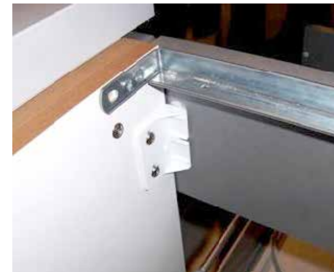
Bærestykke er monteret i de forborede huller.
