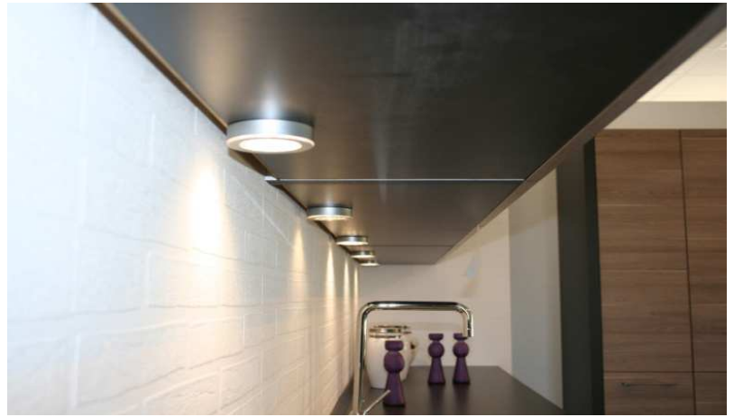
Spot monteres maksimalt 10mm fra bagkant skab.
